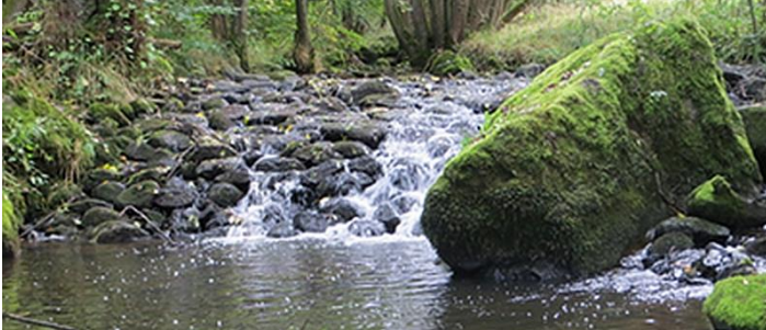
Bild altes Stauwehr der Heckenmühle
